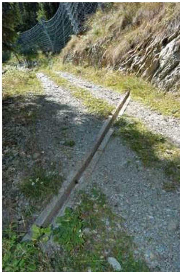
Figura 7-4 Esempio di canaletta di scolo in larice.
